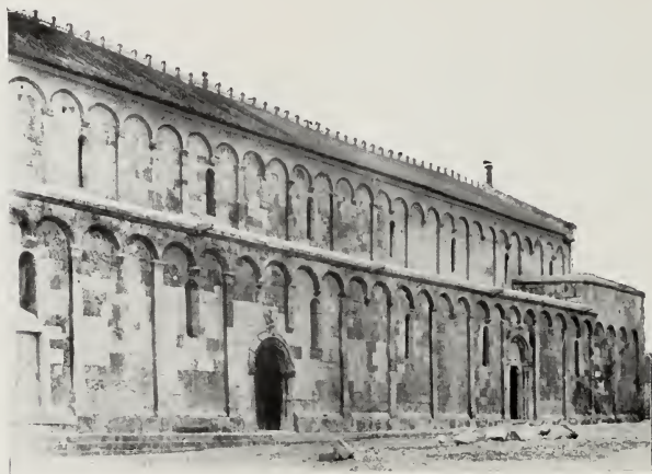
Chiesa di S. Gavino di Torres (fianco).
